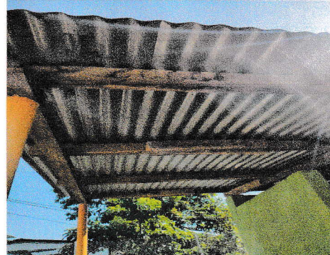
Foto 2: Estructura de techo de sanitarios que equivale a 47 M2.
