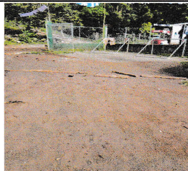
Foto 2: Patio frontal de la escuela con mucho lodo, no se puede caminar por este espacio.
