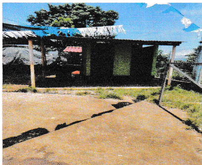
Foto 1: Estructura de techo en sanitarios.
