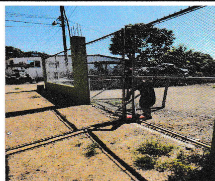
Foto 4: Portón frontal con medidas de 2 metros de alto por 4 de ancho.
